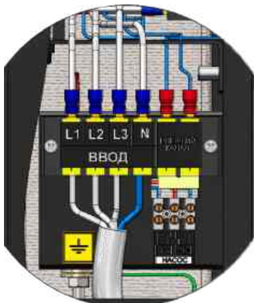
Рис. 6 Схема подключения электроводонагревателя к трехфазной сети 380 В
